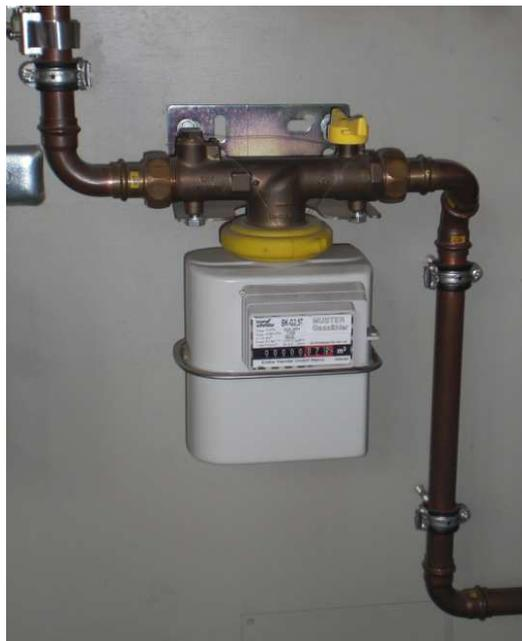
Abbildung 1: Zählerplatte mit Einrohrzähler
