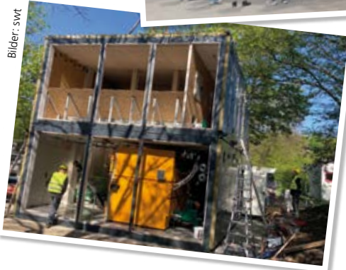
Die Heizzentrale neben der Turnhalle Feuerhägle ist in Containern untergebracht und wurde von Gühring Energie aus Rottenburg errichtet.
