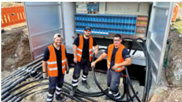
Raphael Fobke, Moritz Hahn und Eric Kamla vom Technischen Service der swt haben eine neue Trafostation errichtet.
