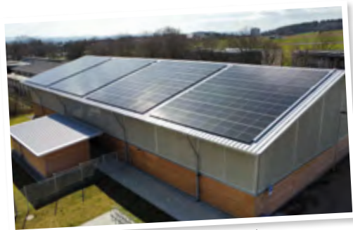
PV-Dachanlage auf der Sporthalle Holderfeld
