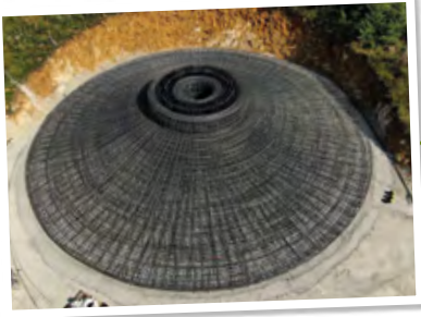
Arbeiten am Fundament einer Windkraftanlage im August 2025. Seit Herbst 2023 wurden die Flächen vorbereitet.
