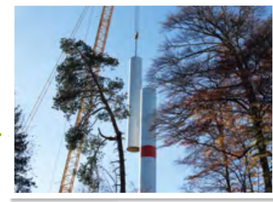
Ende Oktober beginnt der Aufbau der 70 Tonnen schweren Turmteile. Zum Schluss zieht ein Spezialkran die Rotorblätter hinauf.
