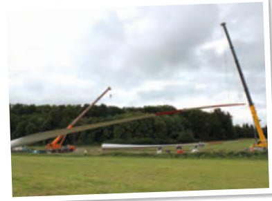
Mikado XXXL: Am Waldrand werden die Rotorblätter mit Kränen abgeladen und zwischengelagert.
