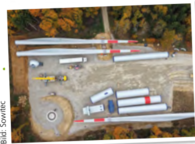
Im Oktober werden die großen Bauteile zu den Standorten der Windräder im Wald transportiert.
