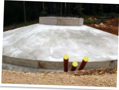
Ufo gelandet? Im September 2025 ist das erste Fundament bereit für die Montage des Turms.
