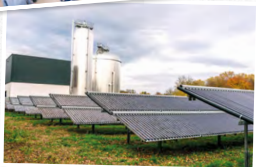
Der Solarthermiefarm an der B 27 mit Röhrenkollektoren, Technikgebäude und Speichern
