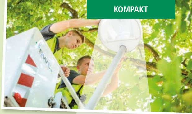
Arbeiten an einer Straßenlampe
