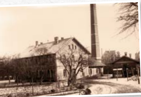
Das Wasserwerk besteht aus einem acht Meter tiefen Grundwasserbrunnen und einer dampfgetriebenen Pumpe, die das Wasser in einen Hochbehälter auf dem Österberg pumpt.
