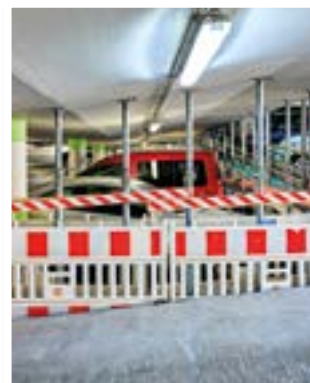
Rechts: Auf Nummer sicher: Unten stützt Metall, in den oberen Ebenen wurden im Mai 260 provisorische Holzpfähle eingesetzt.
