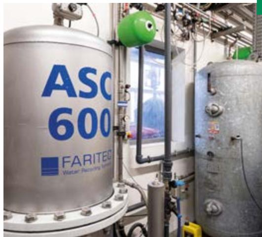
Das Regenwasser von den Dächern wird gesammelt und gefiltert – um dann Waschwasser für Autos zu werden. Auf dem Dach der Waschparks wird Sonnenstrom gemacht.
