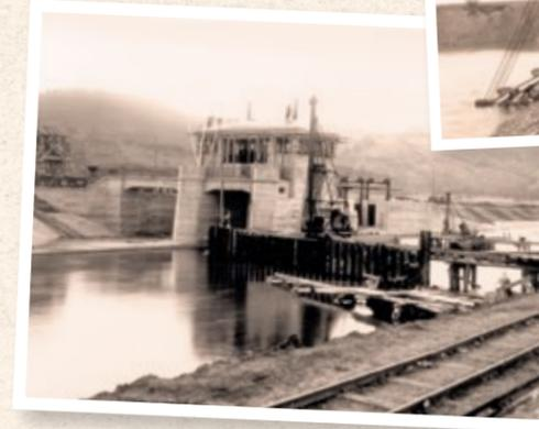
Hirschauer Wehr in Bau (links). Für die Bauarbeiten am Flutkanal und Kraftwerk wurden eigens Gleise verlegt.
