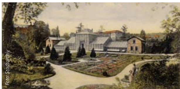
Das Palmenhaus im Alten Botanischen Garten soll neu entstehen
