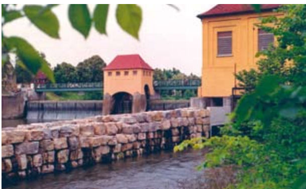
Seit fast 100 Jahren in Betrieb: das Tübinger Neckarkraftwerk
