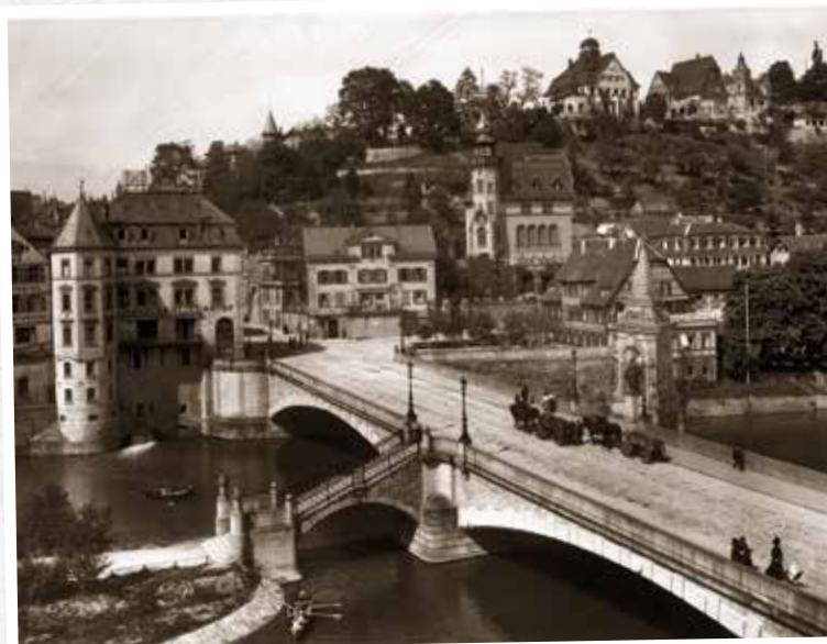
Eberhardsbrücke 1912: seit 1901 für künftigen Straßenbahnverkehr auf 15 Meter verbreitert
